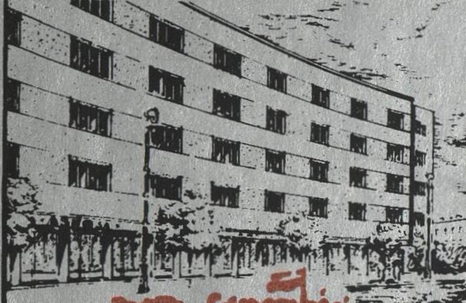
WARSAWA 1918-39 dom pracowników ZUS, pl. Inwalidów 1937
